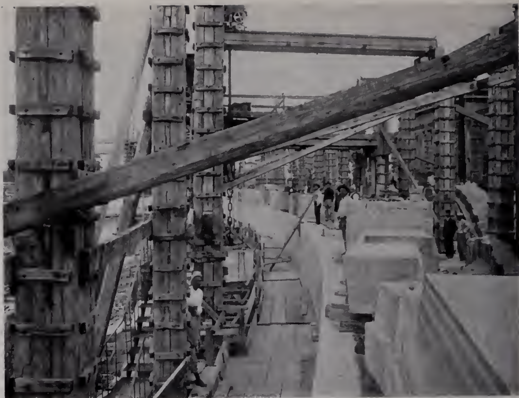
231. — Mentre fervono i lavori
